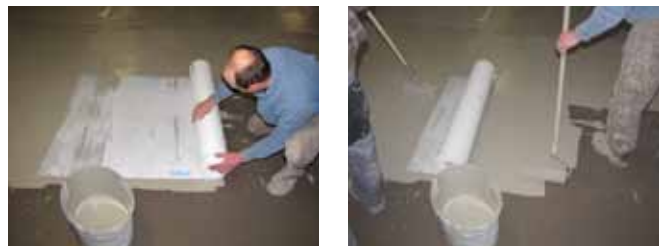
Abbildung 5 & 6: Verarbeitung der Abdichtungslage mit Triflex ProPark
