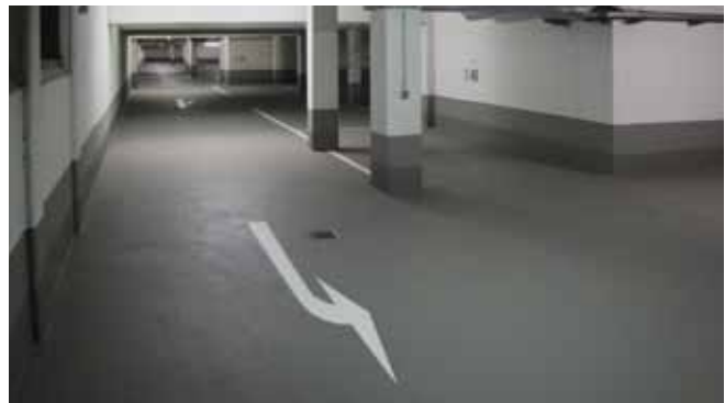
Abbildung 7: Tiefgarage nach erfolgreicher Instandsetzung
